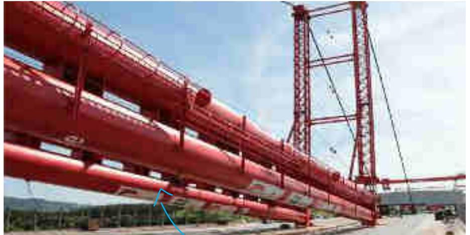
In Einzelteilen wurde der Stahlmast angeliefert, die nach und nach zu einem 83 Meter langen Koloss zusammenwuchsen. Der Mast besteht aus vier dicken Stahlrohren, jeweils 1,6 Meter im Durchmesser. Streben, die dazwischen montiert wurden, halten die vier Rohre zu einem großen Mast zusammen. An diesem sind etwa 1000 Stahlseile, sogenannte Litzen, befestigt.
