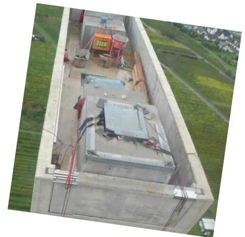
Der Pfeilerkopf - hier wird auf engstem Raum vermessen.
