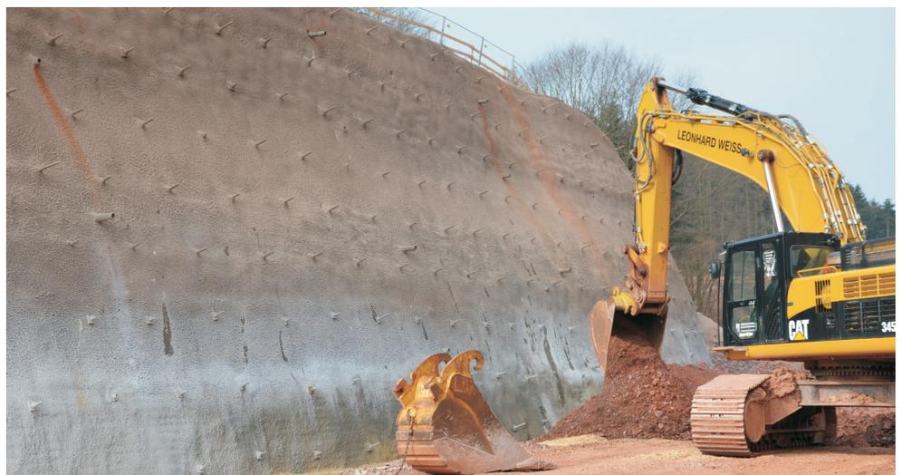
Die Enden der Erdnägel ragen aus der Böschung hervor. Sie sind wichtiger Bestandteil der Baugrubensicherung.
