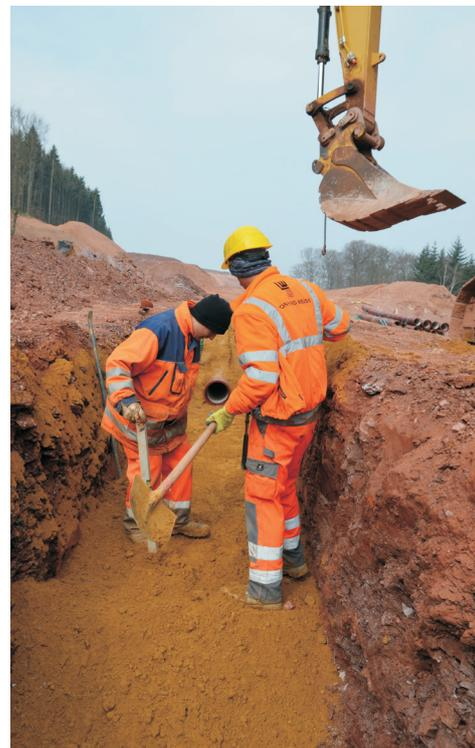
Arbeiter verteilen Sand in dem Graben, durch den das Entwässerungsrohr verläuft.
