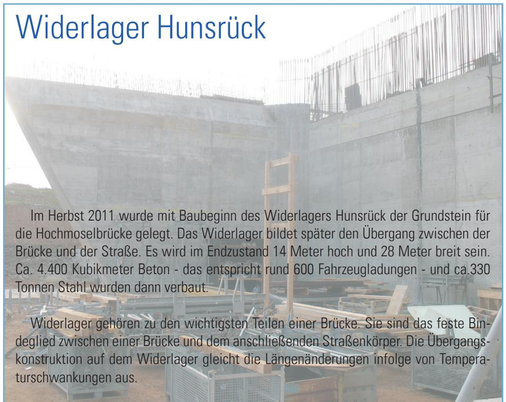
Im Herbst 2011 wurde mit Baubeginn des Widerlagers Hunsrück der Grundstein für die Hochmoselbrücke gelegt. Das Widerlager bildet später den Übergang zwischen der Brücke und der Straße. Es wird im Endzustand 14 Meter hoch und 28 Meter breit sein. Ca. 4.400 Kubikmeter Beton - das entspricht rund 600 Fahrzeugladungen - und ca. 330 Tonnen Stahl wurden dann verbaut.
