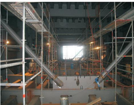
Einbau der Diagonalverstrebung im Überbau
